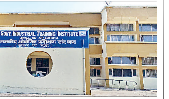
झज्जर। आईटीआई झज्जर एट गुदा भवन का फाईल फोटो। फोटो: हरिभूमि
